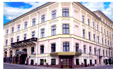
Корпус №1 ЧТЕІ КНТЕУ, м. Чернівці, пл. Центральна, 7
