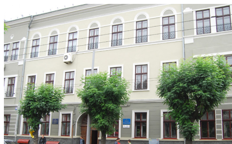
Корпус №2 ЧТЕІ КНТЕУ, м. Чернівці, вул. Головна, 91
